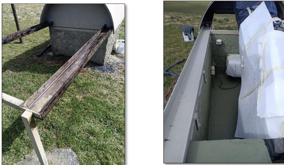
Figura 14 - Manutenção do Shelter do SST
