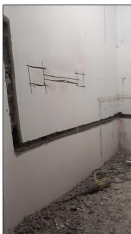
Figura 13 - Obras de construção do duche
