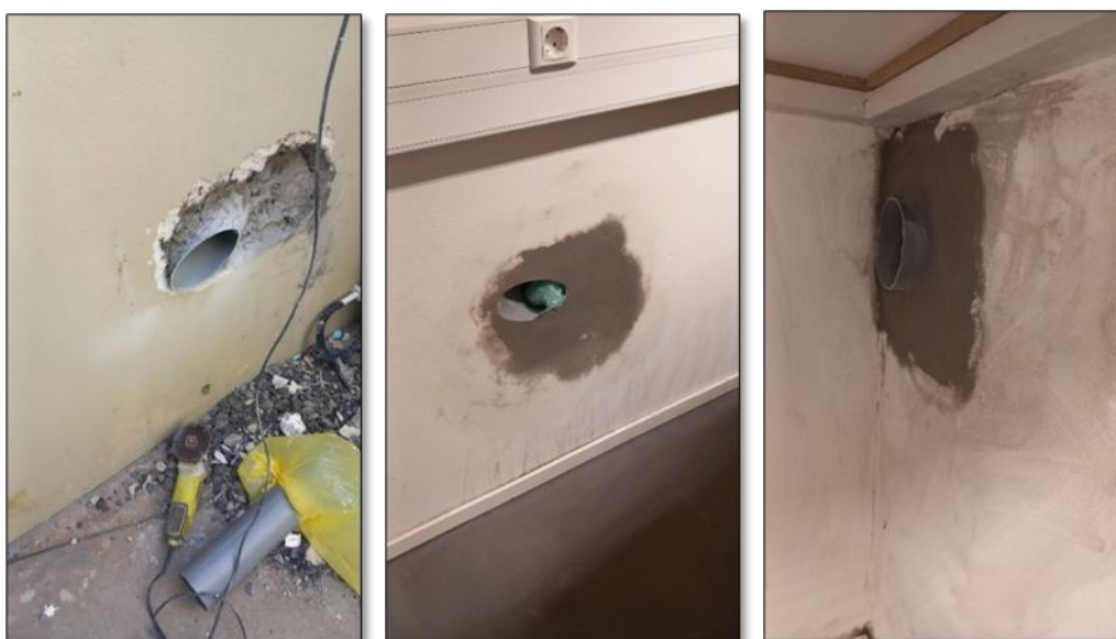
Figura 12 – Obras no Laboratório
