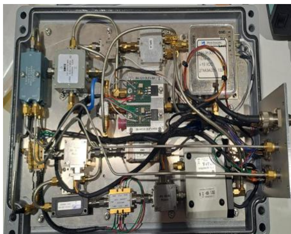
Figura 08 - Montagem do segundo filtro 5G
