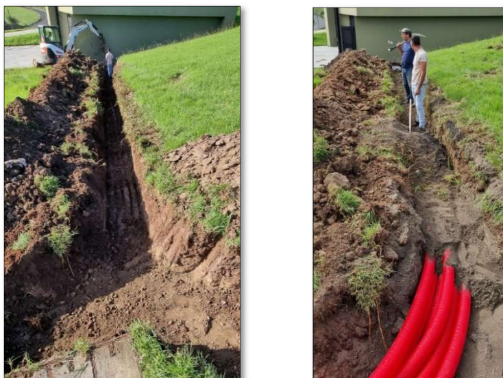
Figura 09 - Abertura da vala para passagem de cabos
