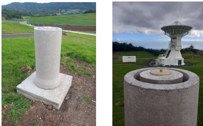
Figura 15 - Pilares do Local Tie finalizados
