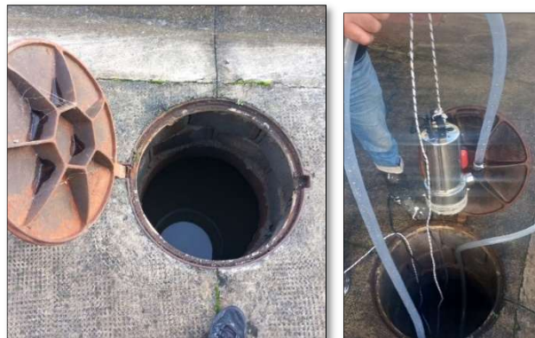
Figura 05 - Limpeza caixas de água
