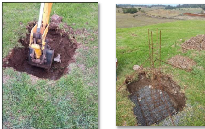
Figura 14 - Início da escavação para execução dos pilares Local Tie
