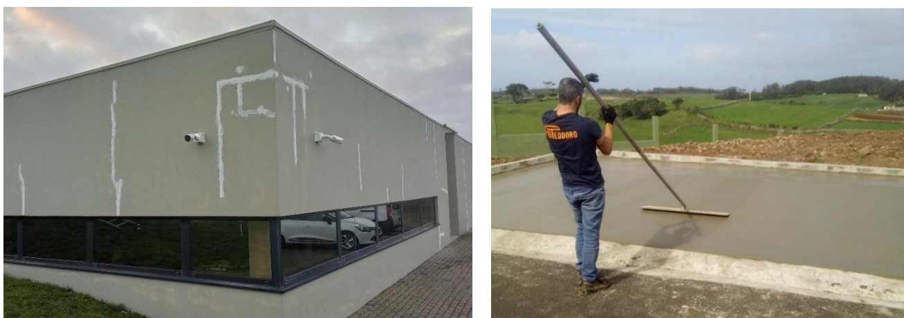
Figura 11 – Tratamento de fissuras na fachada do edifício de controlo; Parque de estacionamento
