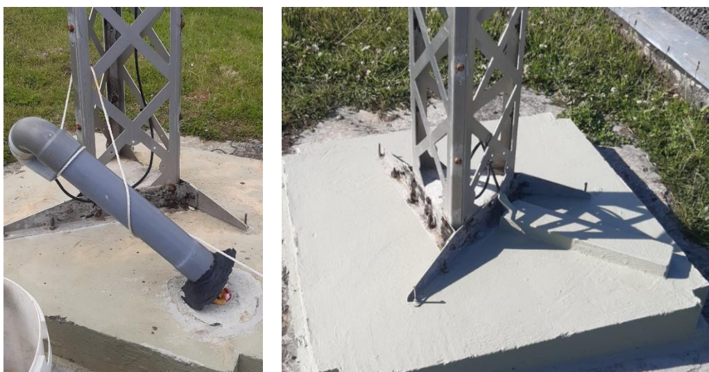
Figura 20 – Base da estrutura da antena SVOM de Santa Maria: Antes e Depois da modificação
