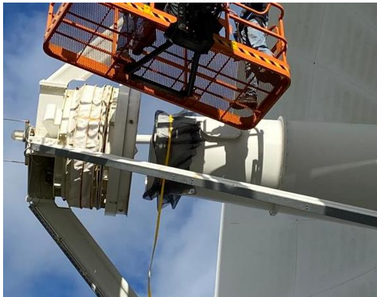
Figura 3 – Montagem do absorvente micro-ondas no radiotelescópio
